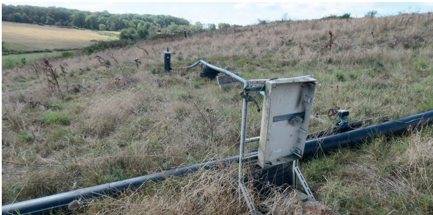
Armoire électrique en voie de désagrégation.
