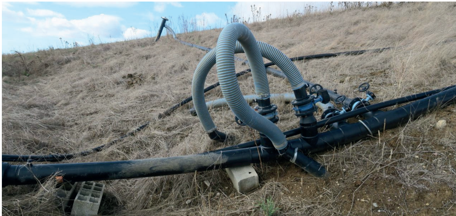
Raccordements des conduits de collecte du biogaz endommagés par les sangliers.
