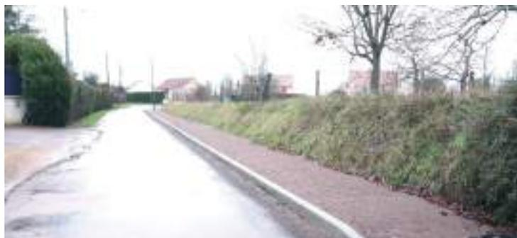
**Route départementale 9E à Ménetreux.** - Création d'un cheminement piétons pour les enfants se rendant à l'arrêt de bus (sécurisation) sur 70 mètres : déblai de terre, bordures béton type T2, enrochement, géotextile et sable stabilisé ainsi que la collecte des eaux pluviales pour un montant total de 17 244.86 euros HT.
