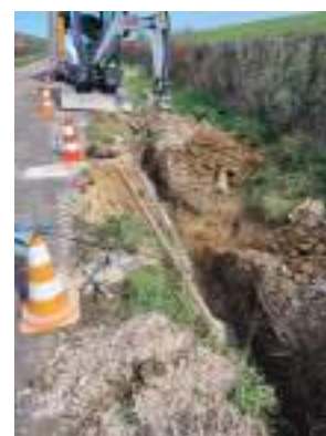
Travaux de réparation de la fibre.
