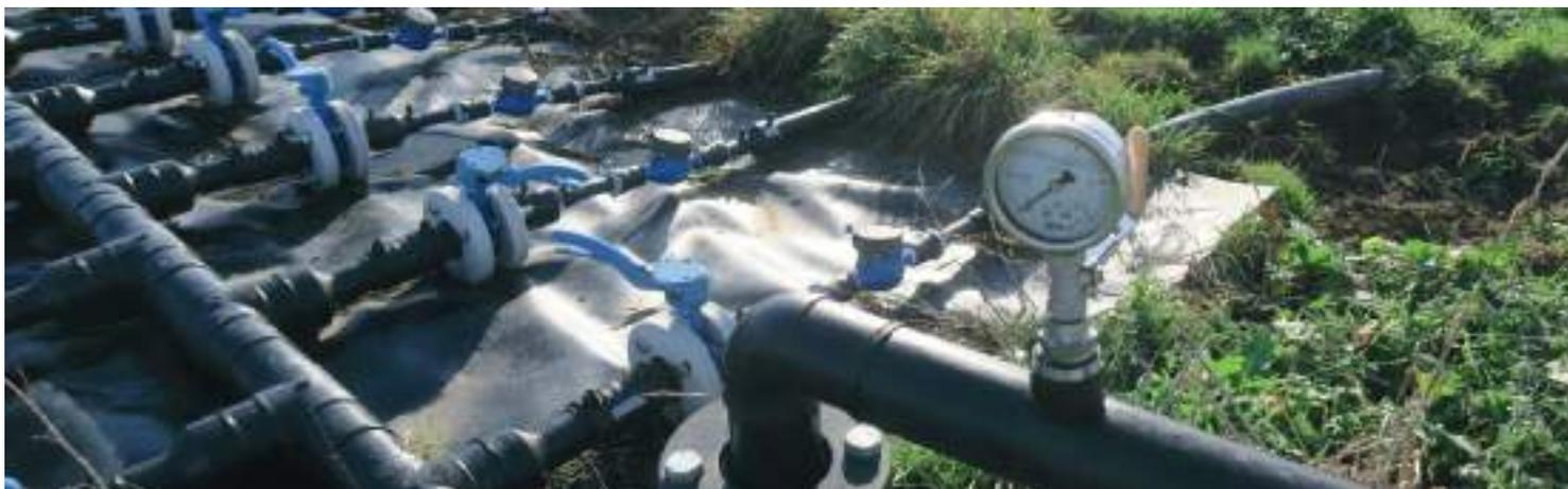
Manomètre indiquant « pression zéro » sur le circuit de réinjection (photo prise le 7 janvier 2023)
