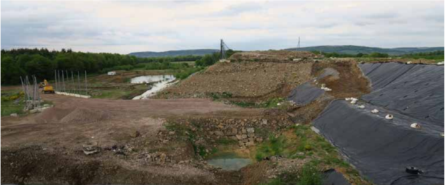
Début du terrassement de la méga-décharge (photo du 18 mai 2019)
