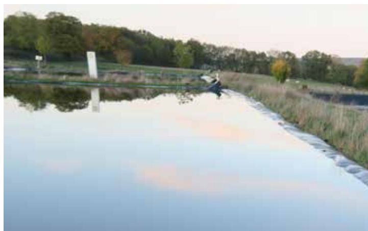
Débordement des bassins de lixiviats (photo du 9 novembre 2019)
