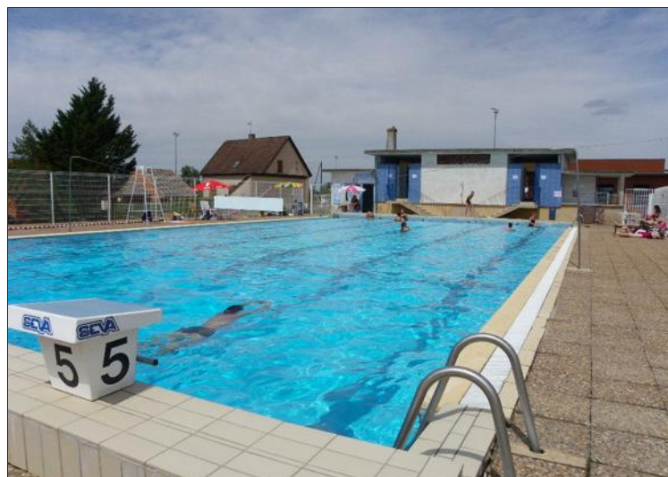
■ Le montant des travaux de la piscine intercommunale d'Époisses avoisinerait les 700 000 €. Photo Archives LBP
