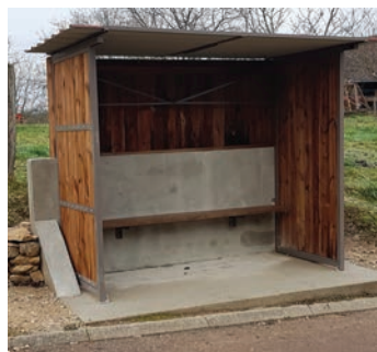
Réfection de l'abribus à Chevigny
