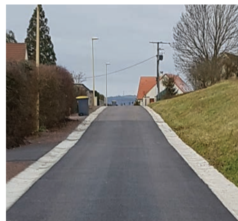
Millery : réfection de chaussée et d'accotements et collecte des eaux pluviales
