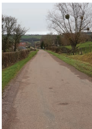
Travaux de voirie à Chevigny
