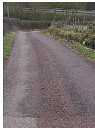
Travaux de voirie à Collonges
