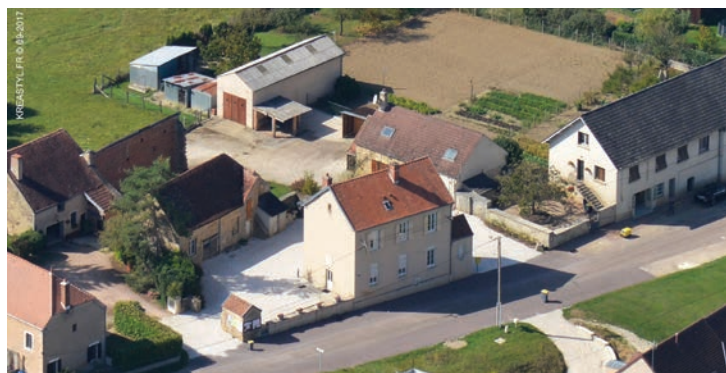
Aménagement de la cour de la mairie et de ses abords en concassé et bicouche
