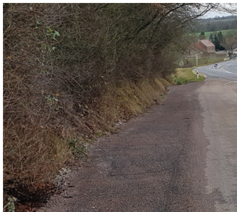
Travaux de voirie au carrefour avec la RD 980
