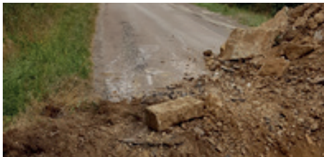
La voirie avant les travaux
