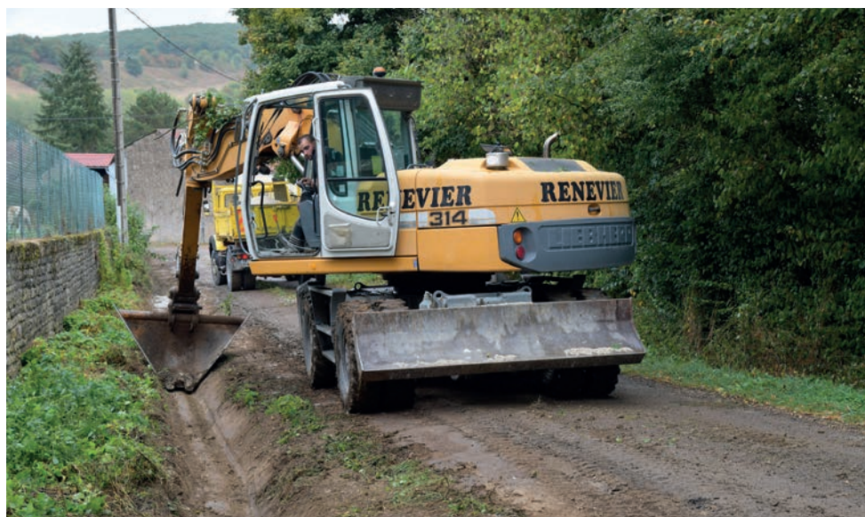
Les travaux rue de la Montagne
