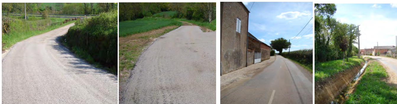
Travaux de voirie : Collonges, Charentois, Ménétreux « haut » et Ménétreux « bas ».
